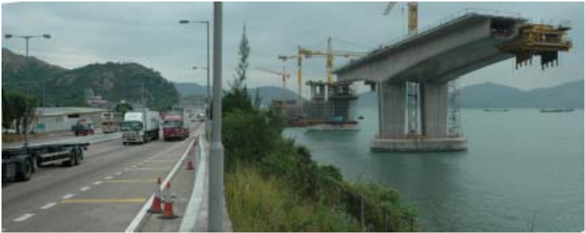
圖21： 施工中期從屯門公路肩旁所見其中一段橋柱及用平衡懸吊、用現場模板澆製方式興建的行車橋道。在全長750米的跨海橋段，共有六組如圖所見的橋柱結構，與海面平均高度約為25米。
