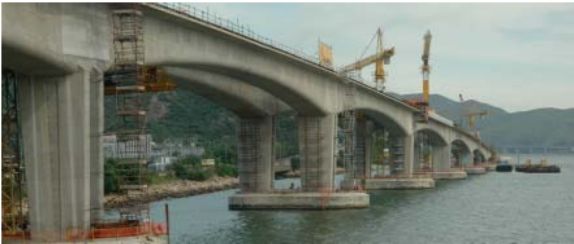
圖24：從小欖橋座位置回望整體結構已完成的大欖跨海橋。
