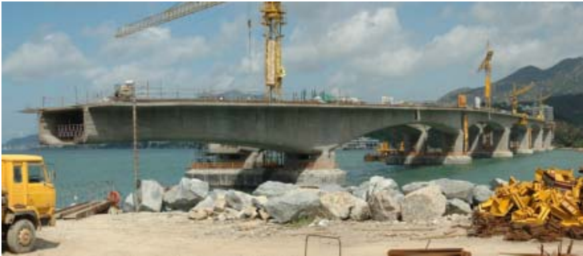
圖23：大橋的跨海段基本接連，正等待最後接駁到位於大欖角及小欖兩端的橋座。
