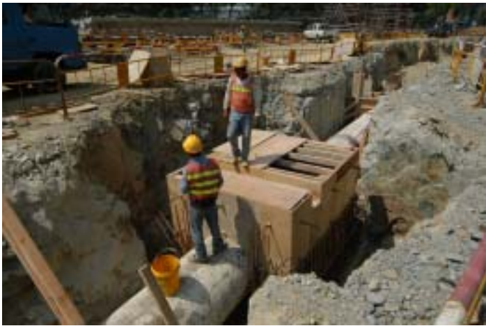
圖54、圖55及圖56：進行地下設施的鋪設，這些設施通常包括水、電、煤氣、通訊，及排洪及污水的管道或渠道等，其中最煩複的是新舊設施的改移、分配和接駁等需要慎密處理的工作。
