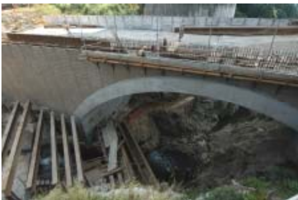
圖52： 大橋施工特寫 - 在小欖落地點所見最後一組橋柱及橋面基座，正利用複雜的鋼模板進行行車橋面的造形和稍後的混凝土澆製。
