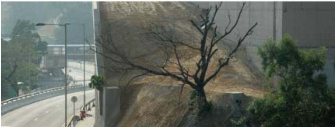
圖43： 一幅接近25米高的新土坡基本完成，等待進行植樹及綠化。正向路邊的擋土牆，在其背後由十數支直徑1.5米的樁柱所支撐，樁柱亦是這沉重的結構牆身的地基。圖正中的一顆正徑較大的樹木受法的保護而需保留，但事後仍然枯死，實覺可惜。雖然這些例案也頗常見，政府及承建商為此也投入了頗大的資源，由此亦可見保護環境的不容易。
