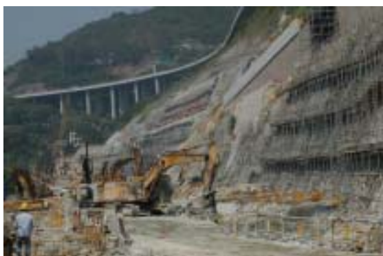
圖2： 開鑿山坡所見的情景。香港的山坡大多屬於石坡，所以開鑿過程十分困難，工時與成本也高，在此段道路擴闊時進行的削坡工作，使用了近兩年的工期，工程費用接近三億港元。
