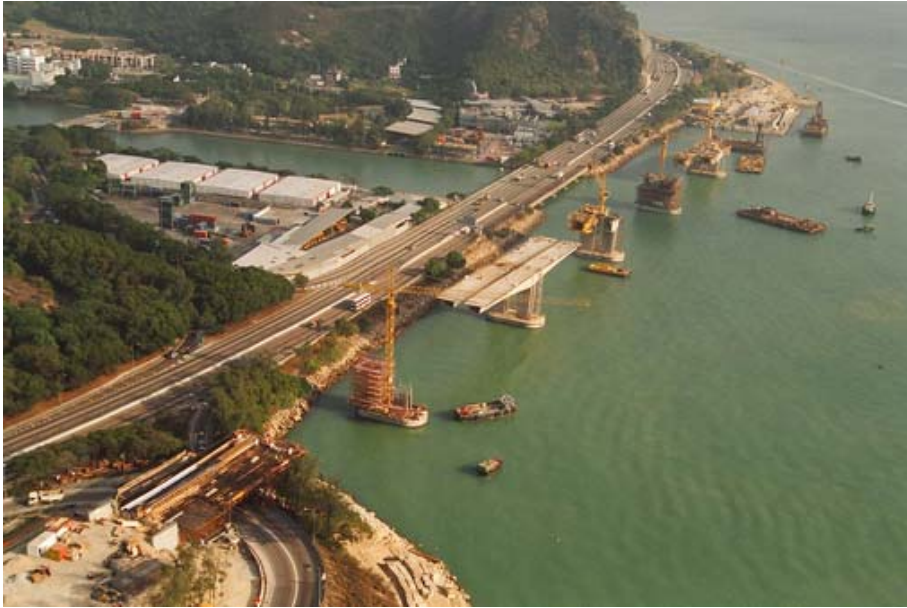
圖18：從空中所見的大欖涌灣，作為青山公路擴闊工程一部份的大欖跨海橋，正在屯門公路旁進行興建。舊青山公路到了這區需要轉入灣內，新橋完成後路段得以拉直，使交通變得暢順。圖左下方的迴旋處為舊青山公路與屯門公路位於小欖的交匯口。
