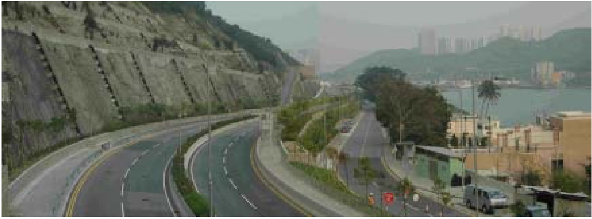
圖27： 從開削山坡而來的土地建成了新的公路路面。舊有的青山公路在圖中的右旁，現變成了給沿海邊的民居成爲一個寧靜和與大路有一個緩衝距離的停車和生活小區。
