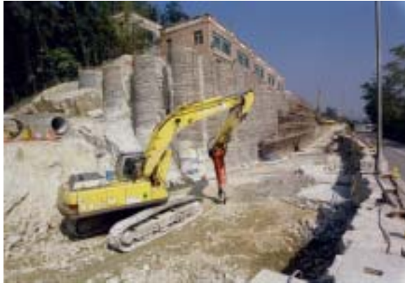
圖41： 另一幅在青龍頭與嘉龍村間受削坡影响的屋宇亦有類似的加固工作，採用大口徑的樁柱支撐緊貼新路邊沿的樓房。稍後，在圖的左方還會興建一條通往這小區的取替新路
