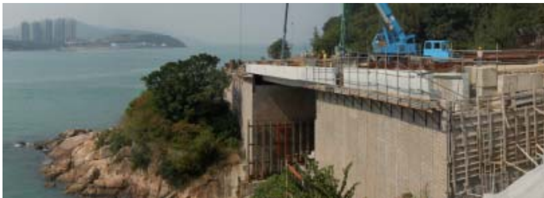
圖5a 及 圖5b： 在岸邊堆填修築的擋土牆正在施工中及後期加闊的路面接近完成的面貌。
