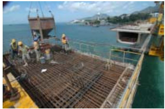
圖51： 在晴朗的一天進行橋面混凝土的澆製
