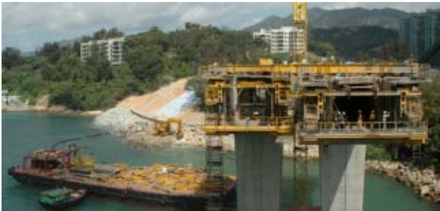
圖52： 大橋施工特寫 - 在小欖落地點所見最後一組橋柱及橋面基座，正利用複雜的鋼模板進行行車橋面的造形和稍後的混凝土澆製。
