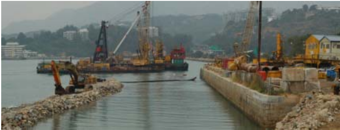
圖19：2004年在大欖角進行的填海，為跨海橋構建一個回落到路面的座基。
