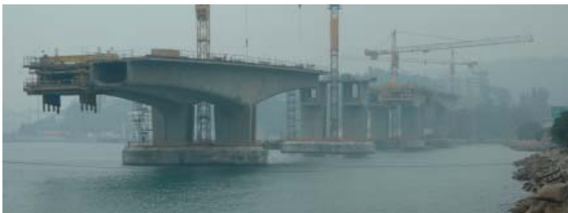
圖22： 跨海橋段結構工作的高峰期，在這階段所有的橋基及橋柱已經完成，大部份的橋面車道亦正在施工中。從晨曦中隱隱可見其宏偉壯闊的氣度。
