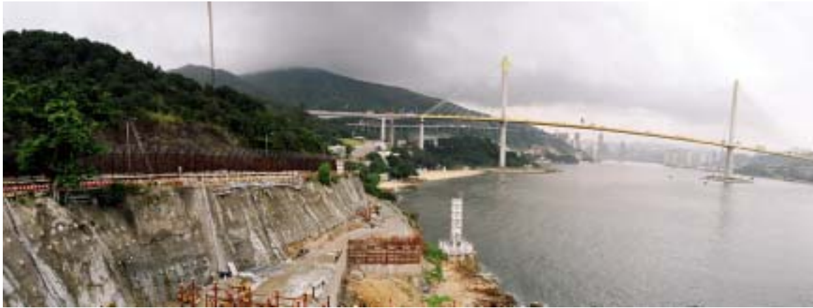
圖4： 擴闊工程早期所見，在更生灣附近狹窄的沙石灘邊進行堆填，準備築堤以興建擋土高牆，形成新的擴闊路面。
